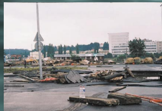
Voda se tehdy přes Strakonickou valila tak, že z ní vyrvala celé velké bloky asfaltu i s podložím
